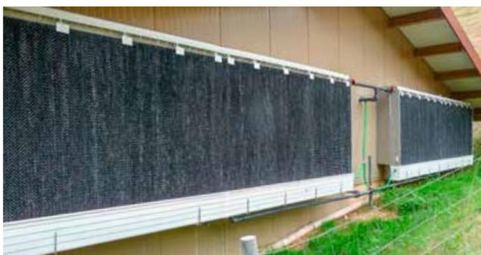
Le système «cool pad» permet de rafraîchir l'air entrant à l'aide d'eau froide.
